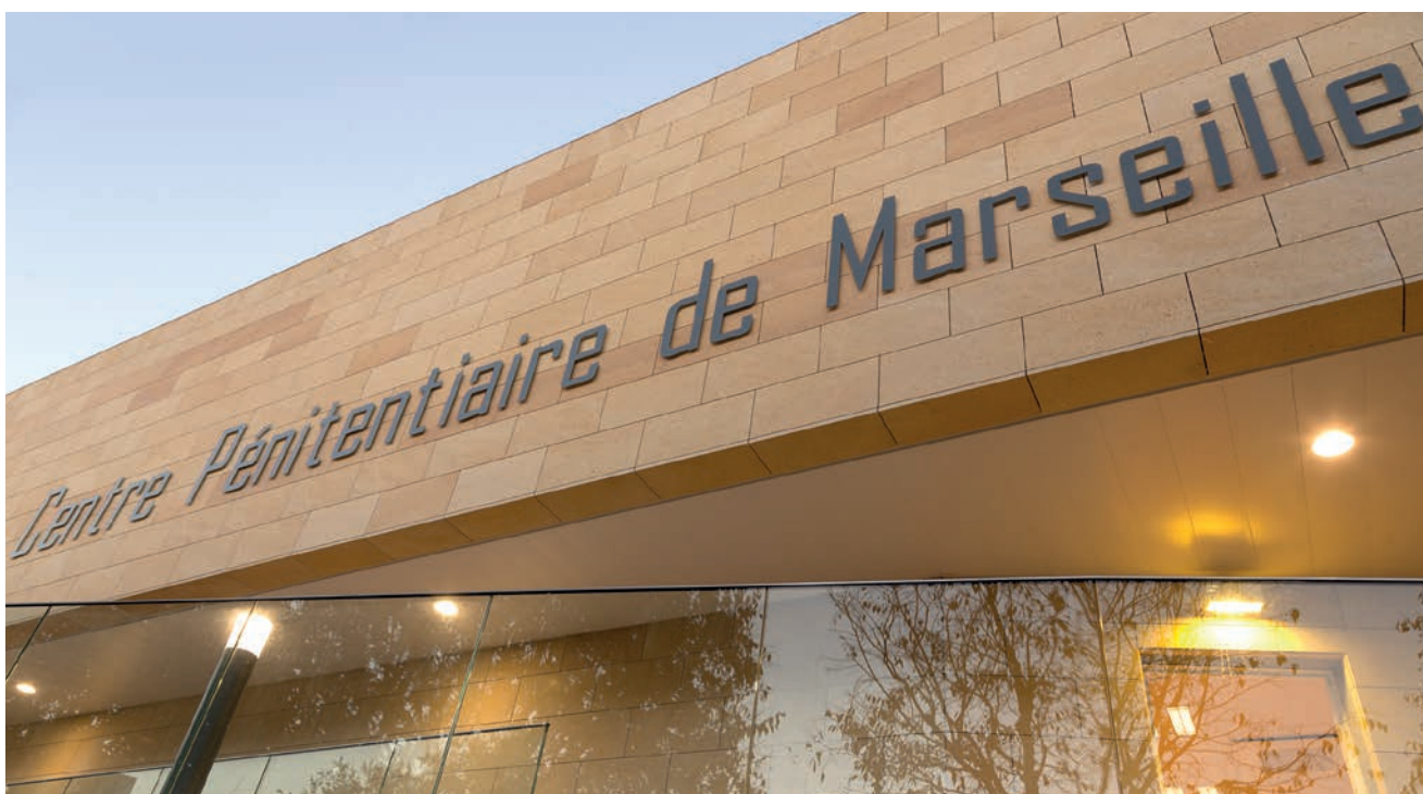
Centre pénitentiaire des Baumettes - Marseille
